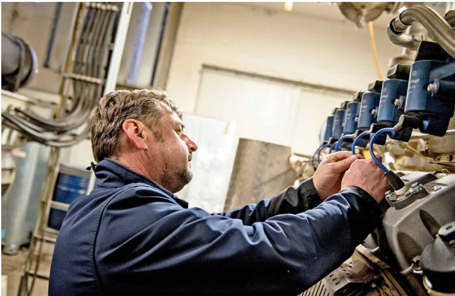
Biogasanlagenbetreiber Paul Schwehofer überprüft die Einstellungen am BHKW im Maschinenraum seiner Anlage in Mertingen, nördlich von Augsburg.
